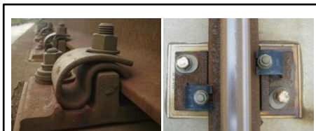
図-1 直結8型締結装置
