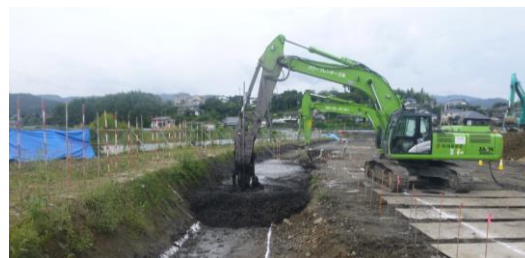
写真-1 地盤改良の施工状況
