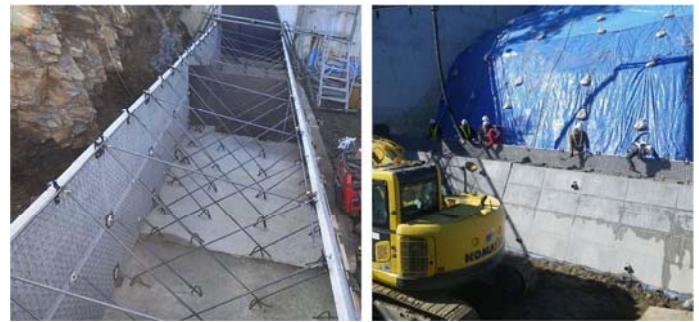
写真-1 残存型枠を使用した側壁護岸 (左：設置状況 右：生コン打設状況)
