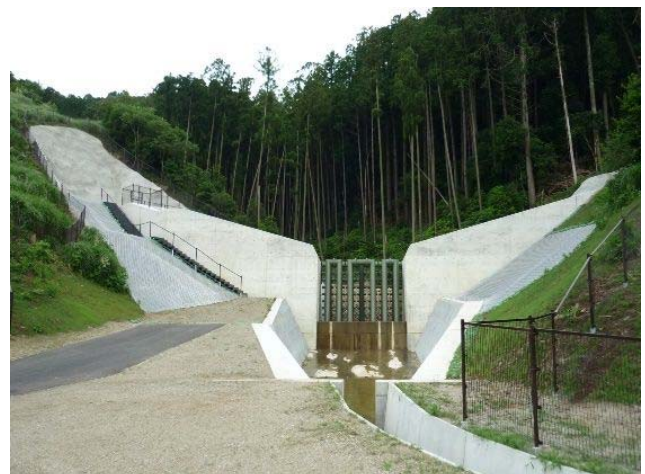
写真-2 砂防えん堤前面の全景
