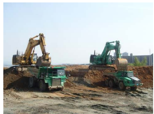
写真-2 大型重機による施工
