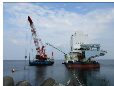
写真-4 間詰めコンの打設状況
