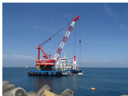
写真-2 ブロック据付け状況
