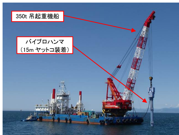
写真-1 鋼管矢板の引抜き状況
