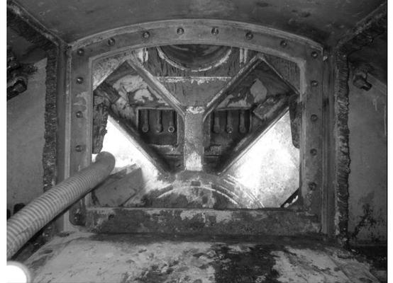
写真-3 J管側凍結管接続部
