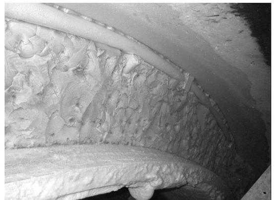
写真-4 J管フード内凍結状況
