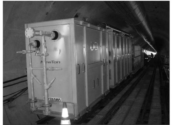
写真-1 凍結プラント設置状況
