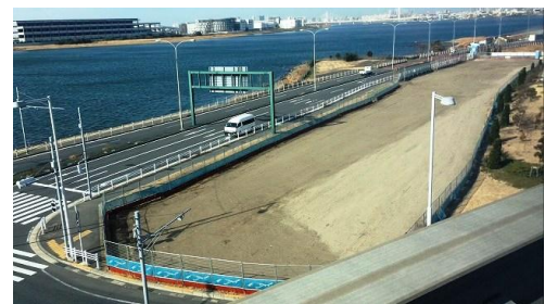
写真-5 施工後の状況
