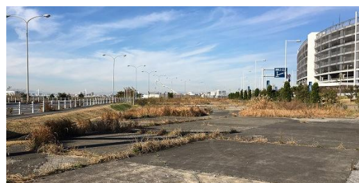
写真-2 舗装版撤去前
