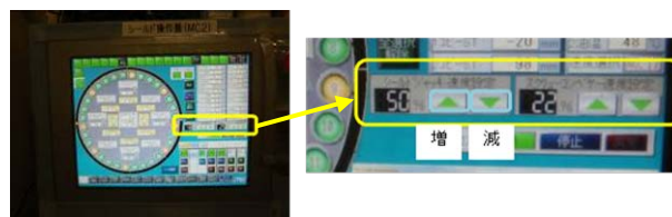
図-1 シールド機の操作画面
