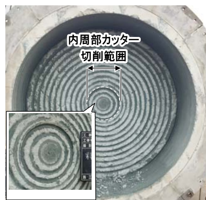
図-2 切削完了後の模擬地盤
