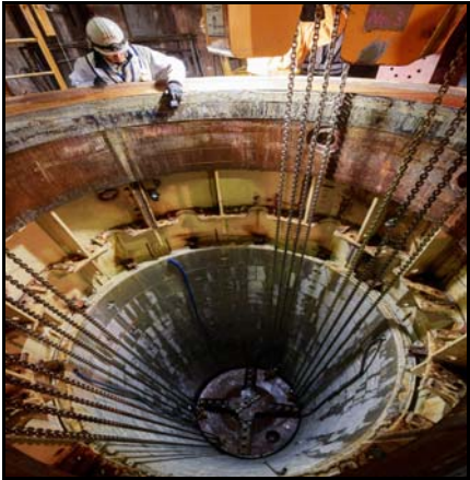
写真-2 坑内回収状況
