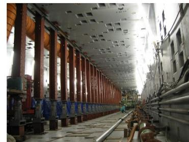
写真-2 仮設中柱(@1.0m)
