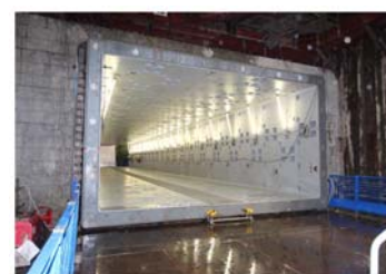
写真-2 通路完成状況
