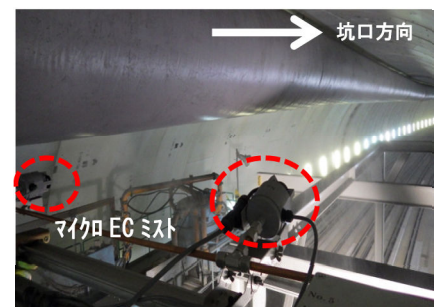
写真-1 ミクロ EC ミストの噴射状況
