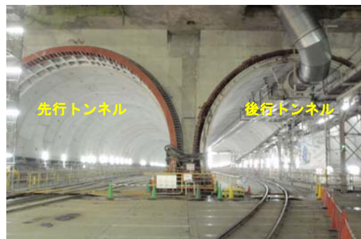
写真-1 先行後行トンネル併設状況
