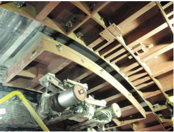
写真-2 セグメント組立状況
