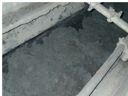
写真-3 現場での排土状況
