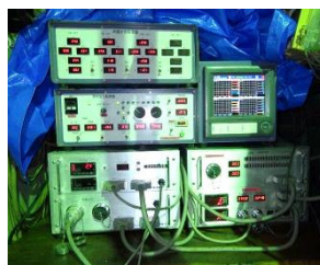
写真-2 推力監視状況
