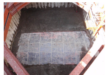
写真-1 再掘削状況
