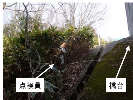
図-5 点検経路の状況(橋台近傍の法面部)
