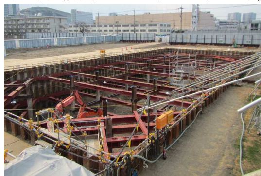
写真-1 変更後 仮設土留全景
