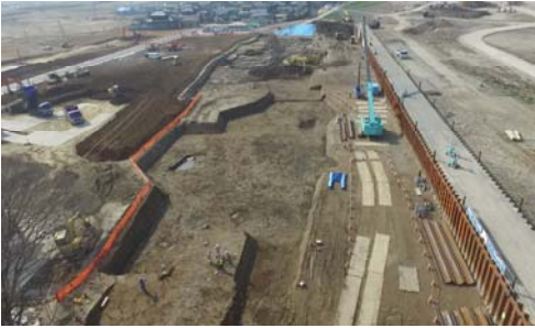
写真－2 施工基面の整形掘削状況
