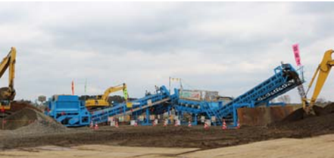
写真－3 万能土質改良機による混合状況
