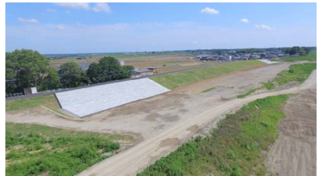
写真-1 本復旧堤防の完成全景
