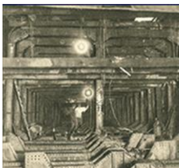
写真-2 鉄構框の組立状況
