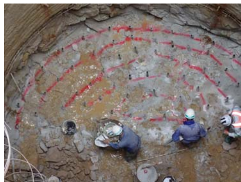
図6 半断面の穿孔例
