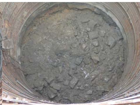
図8 全断面の破碎後
