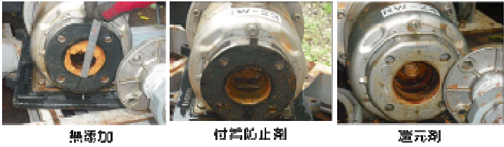
写真-2 試験後ポンプ内状況
