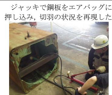
写真-4 耐圧試験状況
