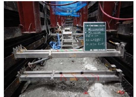
写真-1 水圧ジャッキの設置状況
