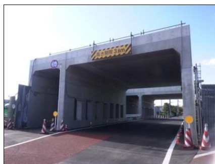
写真-1 市道0229号仮供用の開始状況
