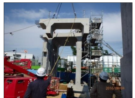
写真-2 プレキャスト部材の設置状況
