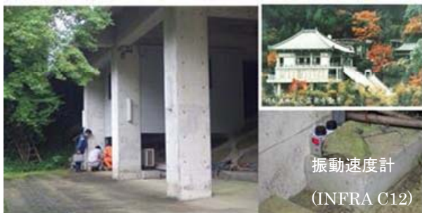
写真-1 近接寺院での測定器設置状況
