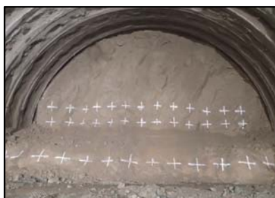
写真-2 探査測点
