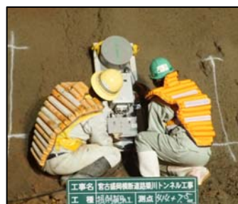
写真-1 探査状況
