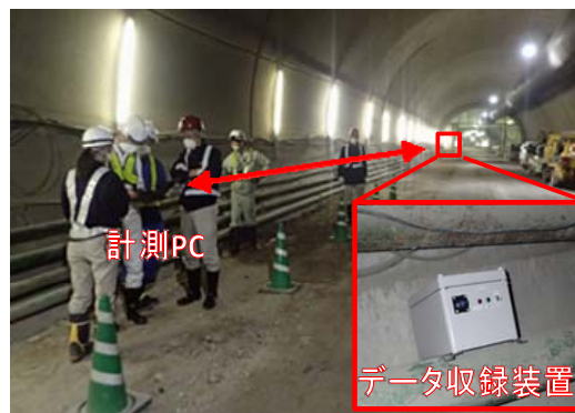
図-4 トンネル坑内通信試験
