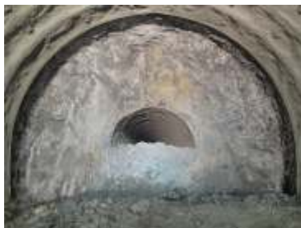
写真-1 球面切羽前景 CⅡ-b(f)
