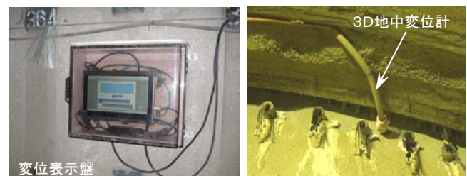
写真－2 計測状況（現場適用実験）
