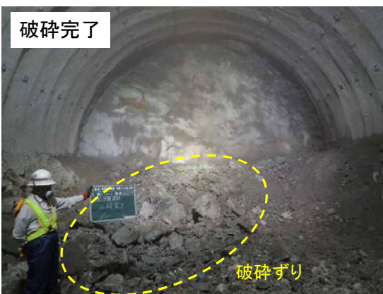
写真-3 装薬完了および破碎完了
