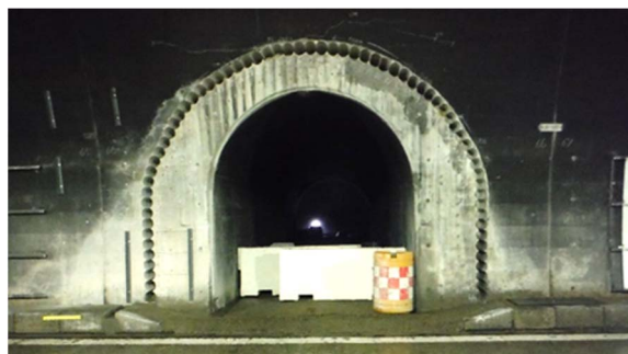
写真-1 コアボーリング施工状況
