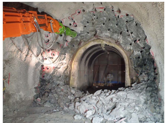
写真-4 割岩状況
