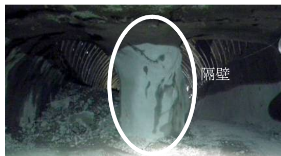
写真-1 隔壁現況写真
