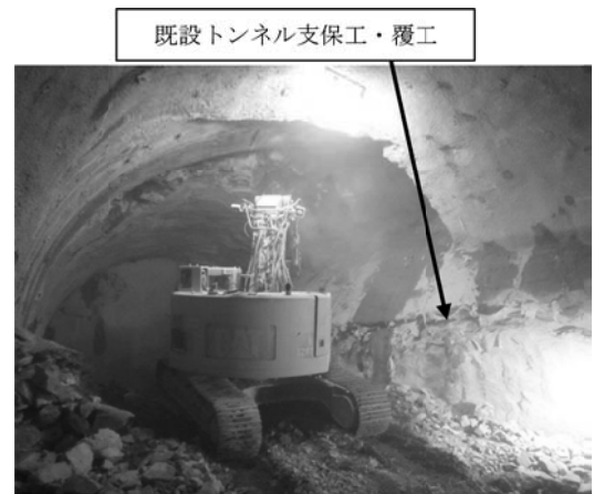
写真-1 掘削状況
