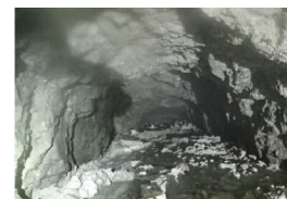
対策工A 充填状況（廃坑道内部）
