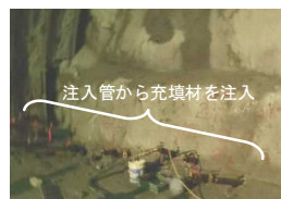
対策工A 充填状況（切羽側）
