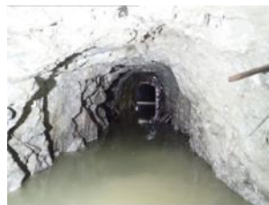
廃坑道交差部付近
