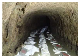
対策工D 排水管設置状況
