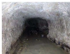
到達坑口付近
