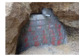
対策工D 廃坑道入口隔壁設置状況
