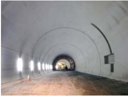
写真-5 覆工完了
