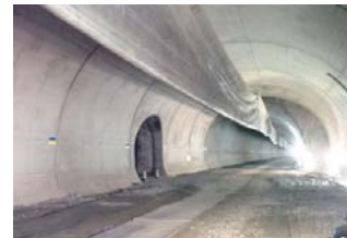
写真-2 敷鉄板による中央排水養生
