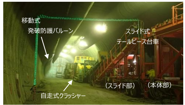
図-2 高速ずり搬出システム
