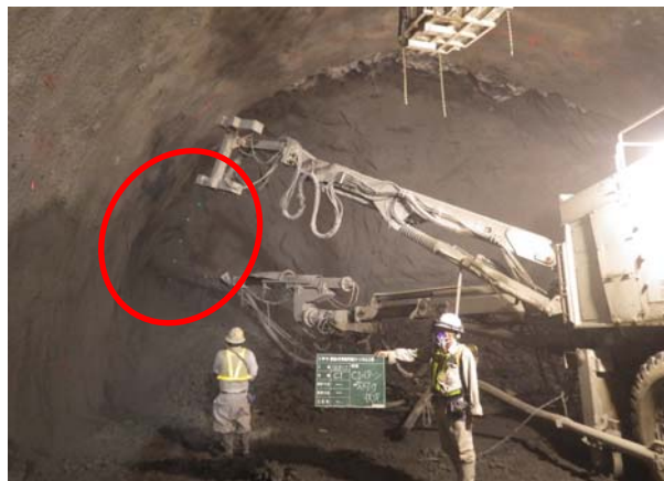
写真-2 クリアショットによる吹付け
