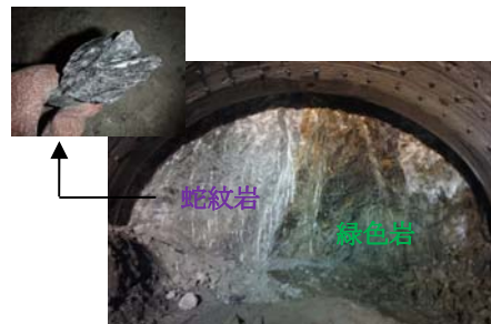
写真-1 蛇紋岩および緑色岩からなる切羽状況 (計測B実施断面)
