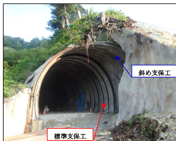
写真-1 斜め支保工による貫通
