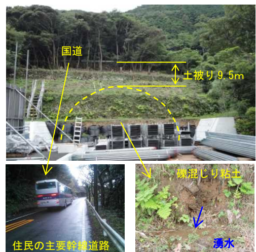
写真1 発進側坑口の状況
