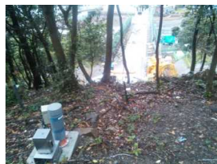
写真4 層別沈下計の設置
