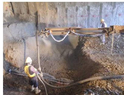
写真3 早期閉合の施工状況
