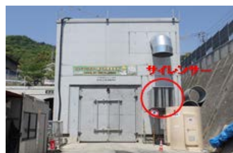
写真-1 防音ハウス
