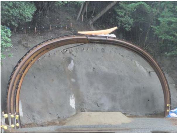
写真-1 坑口部支保工建込完了状況
