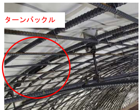
写真1 段取り筋システム
