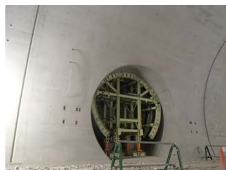
写真 4 高密度配筋部の仕上がり
