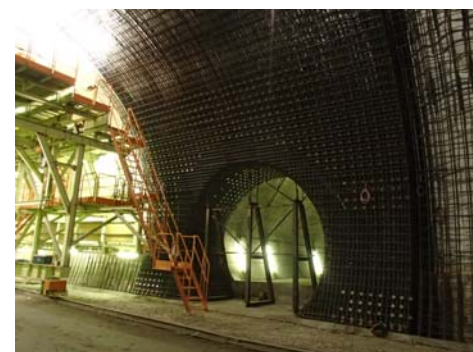
写真 3 非排水構造区間交差部配筋
