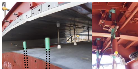
写真-1 伸縮バイブレータ
