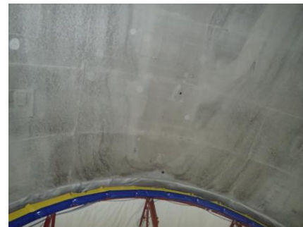
写真-1 覆工表面状況（天端部）
