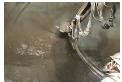
写真-1 吹付け状況
