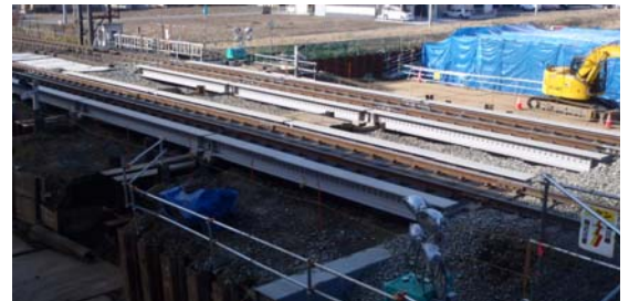
図-1 鉄道用工事桁設置例
